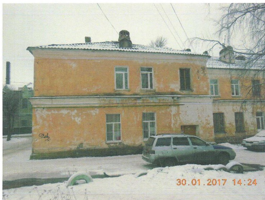
Фото 4. Фрагмент южного (дворового) фасада. Фото Никольского А.Г.
