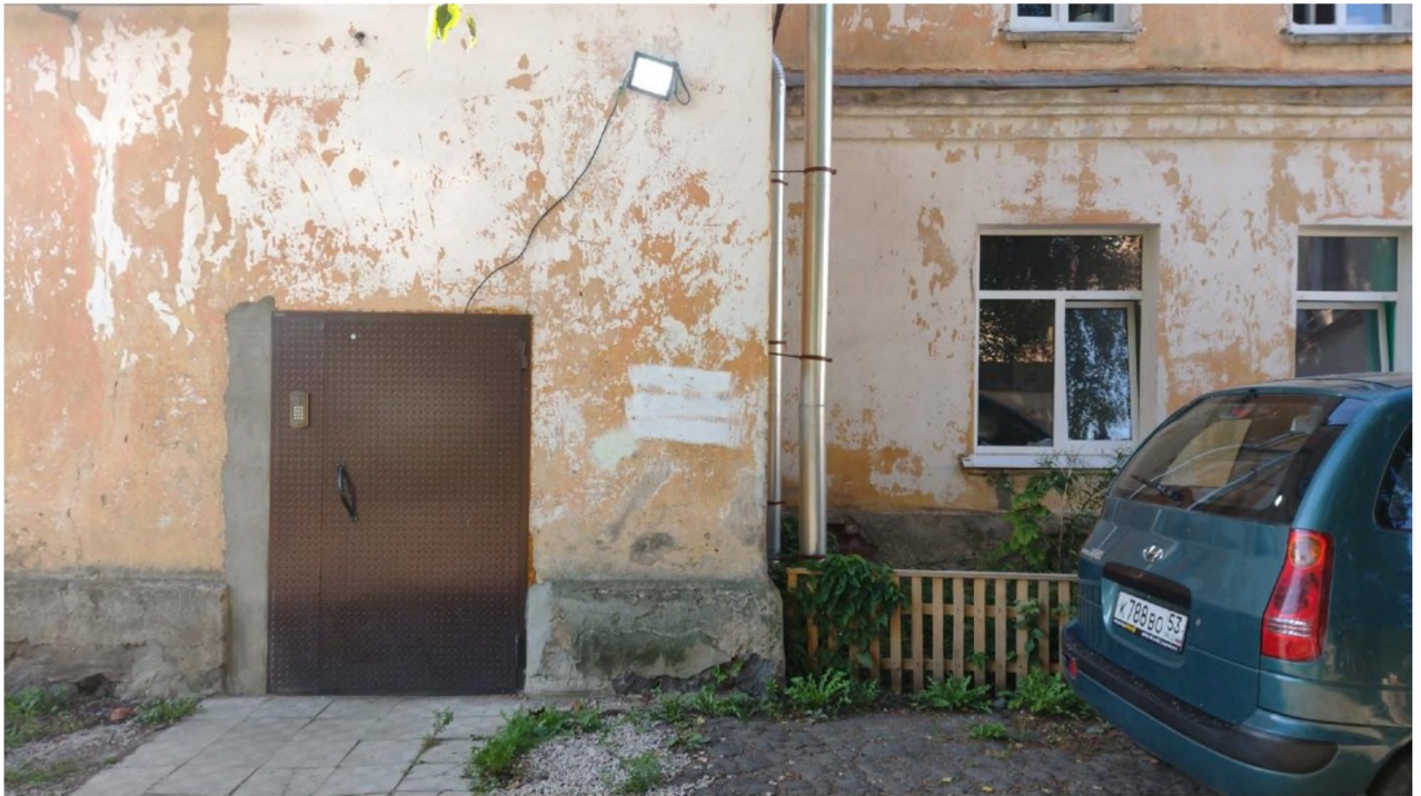
№ 14. Северный (дворовой) фасад. Вход в подъезд. Фото сентябрь 2023 г. (Ефимова Ч.А.)
