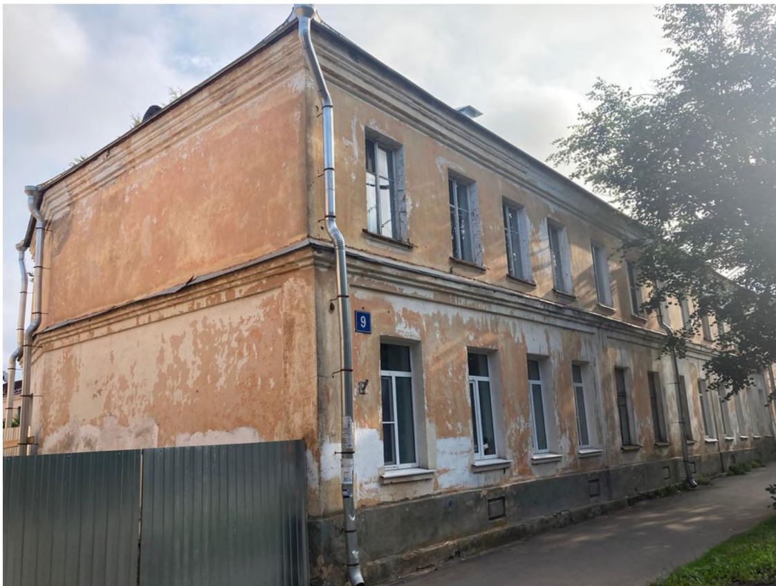
№ 1. Южный (лицевой) фасад и западный (торцевой) фасад. Фото сентябрь 2023 г. (Фатеева А.А.)
