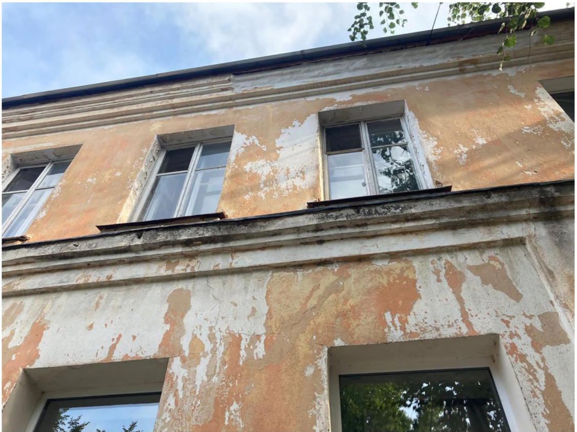
№ 4. Фрагмент южного фасада. Вид на карниз. Фото сентябрь 2023 г. (Фатеева А.А.)
