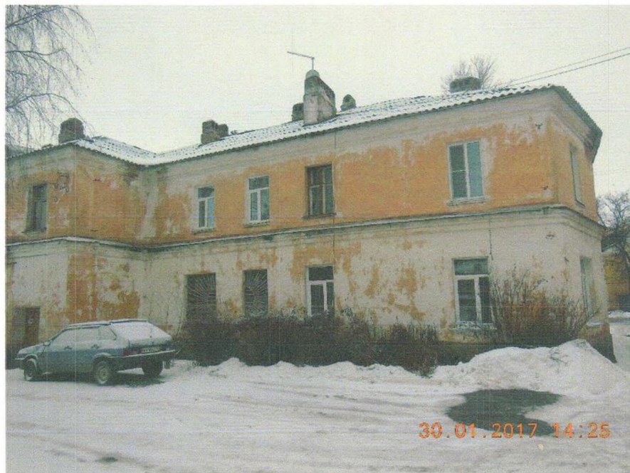
Фото 5. Фрагмент южного (дворового) фасада. Фото Никольского А.Г.
