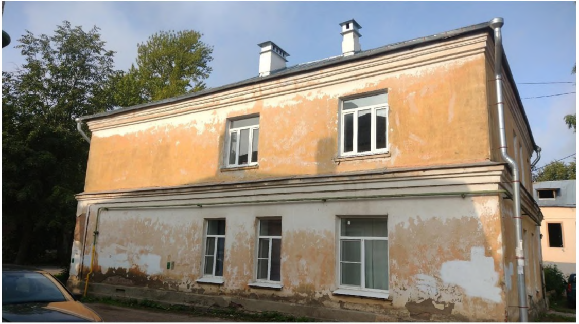
№ 5. Восточный фасад. Вид с северо-востока. Фото сентябрь 2023 г. (Ефимова Ч.А.)
