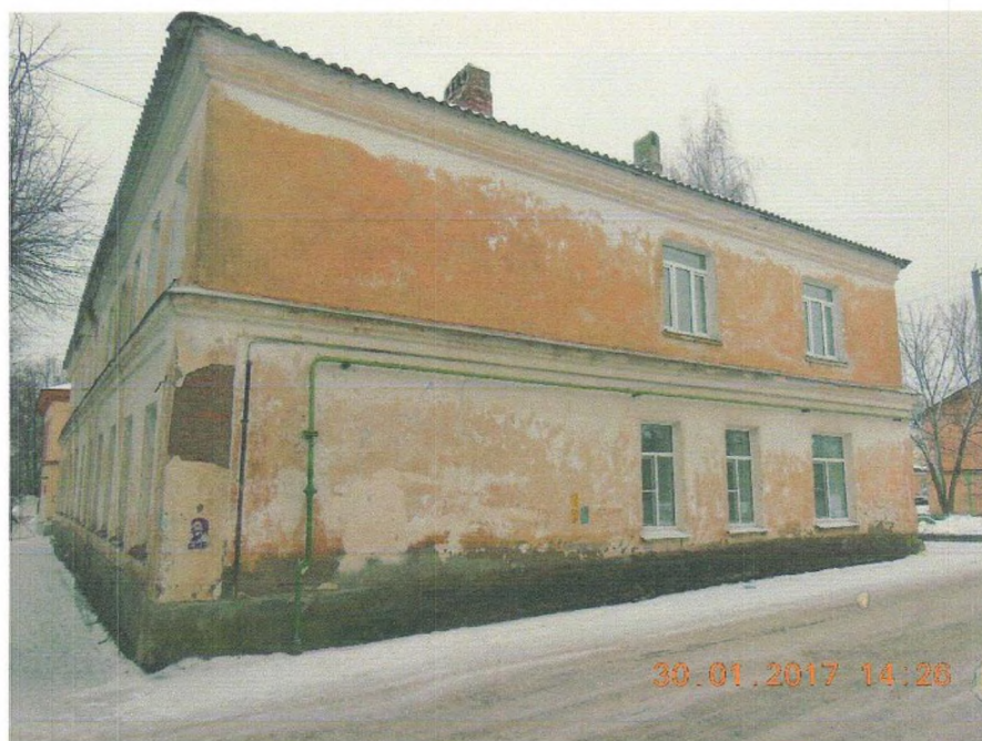
Фото 6. Восточный торцевой фасад. Фото Никольского А.Г.
