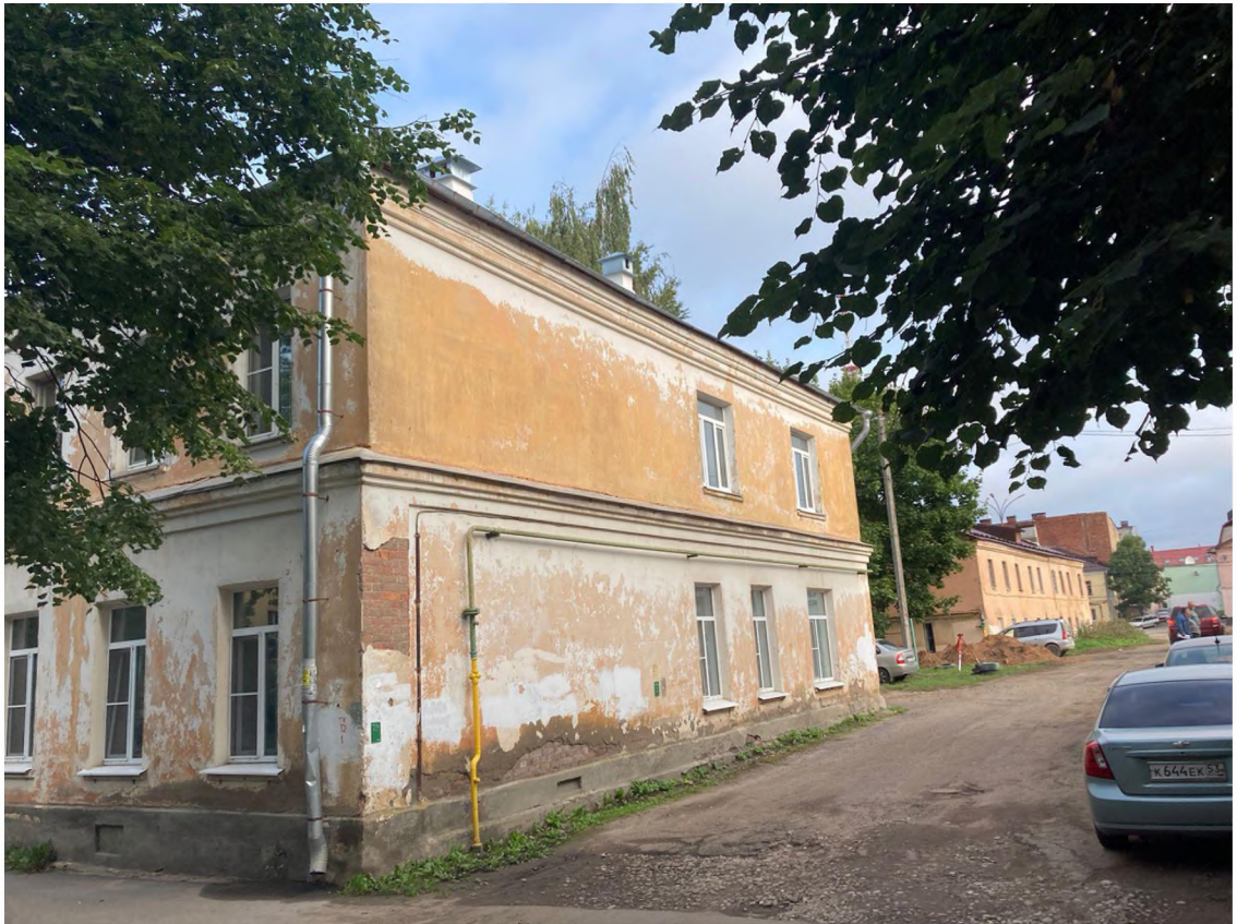
№ 6. Восточный фасад. Вид с юго-востока. Фото сентябрь 2023 г. (Фатеева А.А.)
