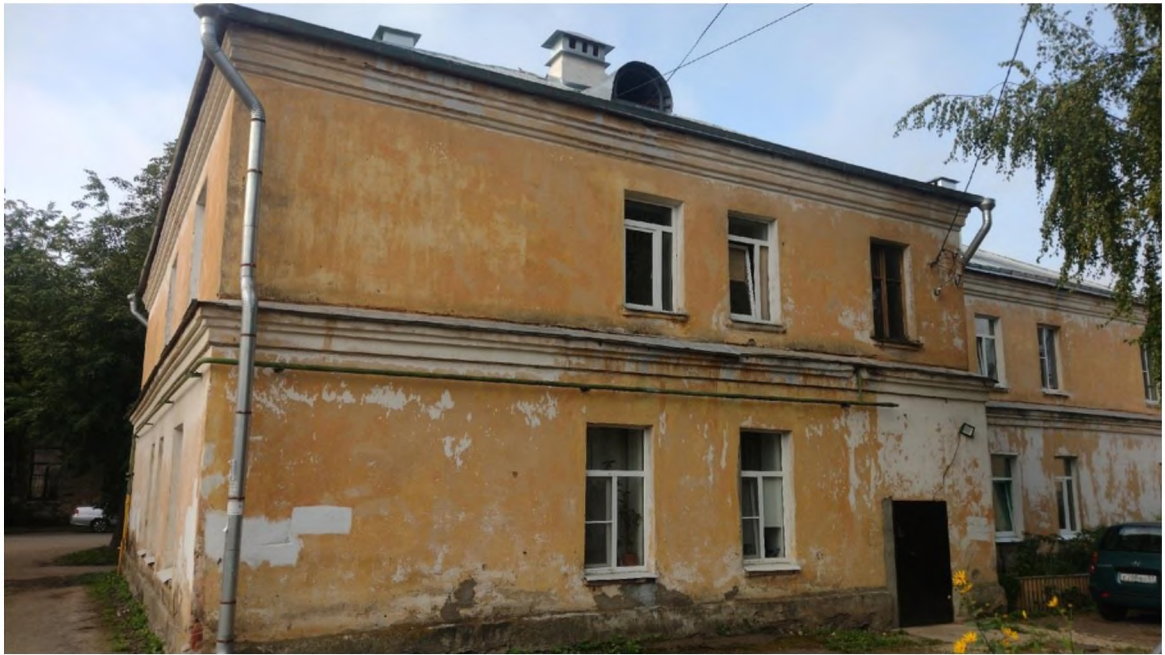
№ 12. Северный фасад. Фото сентябрь 2023 г. (Ефимова Ч.А.)
