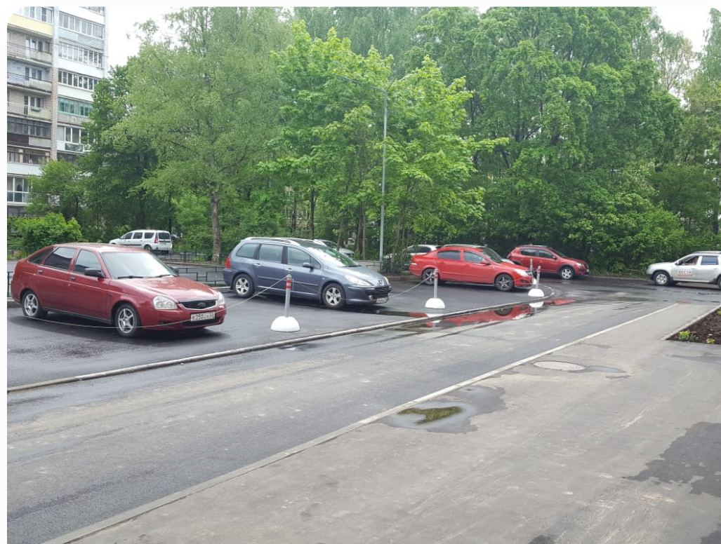
Процесс благоустройства двора по адресу ул.Мира д.25, к.1
